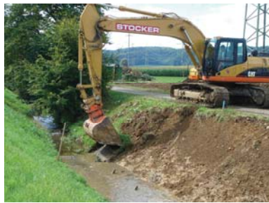
Mit einem Bagger wurde 2006 die Böschung abgetragen. Das Erdreich wurde von den Rhizomen des Knöterichs befreit
