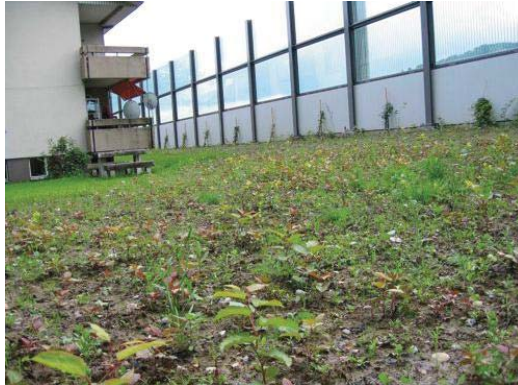
Auf dieser Baustelle wurde rhizomhaltiger Boden eingebaut. Weil der Boden nachher ausgetauscht werden musste, sind Kosten von 13'500 Franken entstanden (Foto planikum GmbH).
